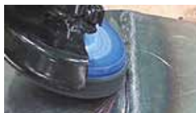
*Usuwanie niebieskich przebarwień spoin
