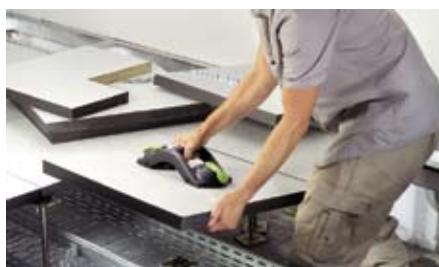
Przy układaniu podłóg w biurach oraz paneli laminatów podwójny uchwyt przyssawkowy jest bardzo pomocny.
