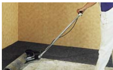
W swobodnej pozycji łatwiej się pracuje. Rękocyść można ustawić do wysokości cięcia.
