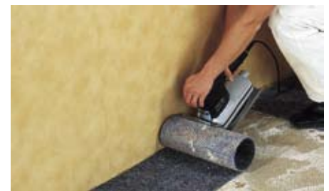
Także w narożach maszyna do usuwania wykładzin świetnie się spisuje.
